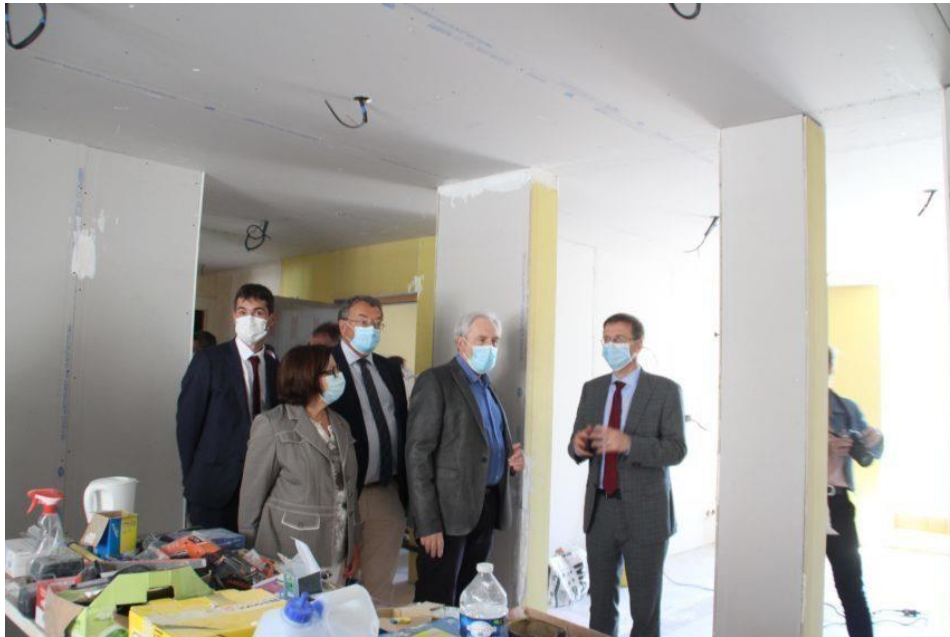
Cinq logements vacants très dégradés font l'objet d'une rénovation, à Vire Normandie. (©La Voix Le Bocage)
