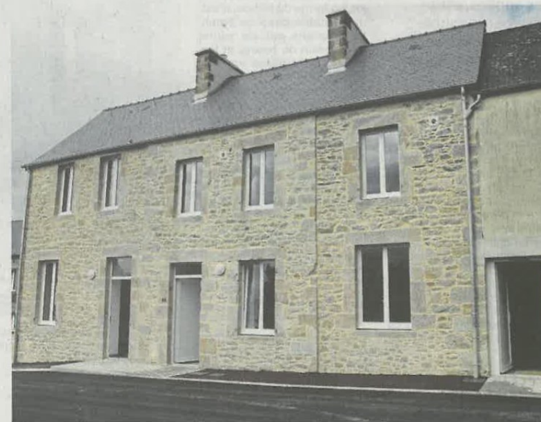
L'ancienne école-mairie est transformée en trois logements locatifs.
